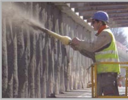
Feinbetonpumpen, wie die P 715, zählen zu den vielseitigsten Systemen. Sie können sie für Spritzbeton einsetzen oder für das Pumpen von Feinbeton bis 16 mm.
